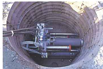
塩ビ管推進状況
