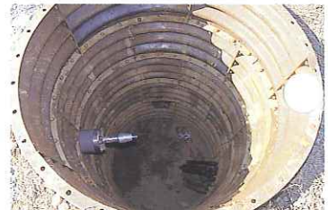
先頭カッター及び埋設管到達状況
