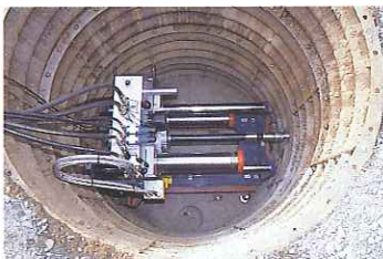
スピダーヘッド及びリード管推進状況
